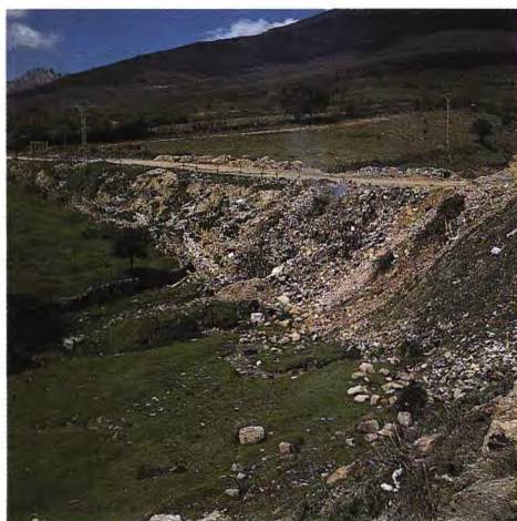
Efectos de terraplén motivados por la construcción de una carretera.
