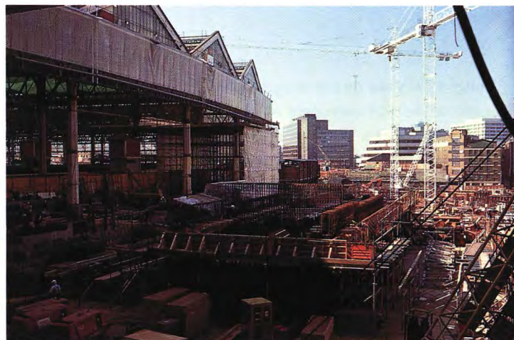
La terminal de Waterloo para el Túnel del Canal está en construcción.
